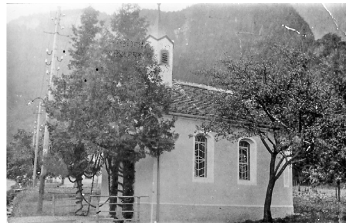
Gut zu erkennen sind der offene Krumbach und die oberirdi- sche Stromleitung.
